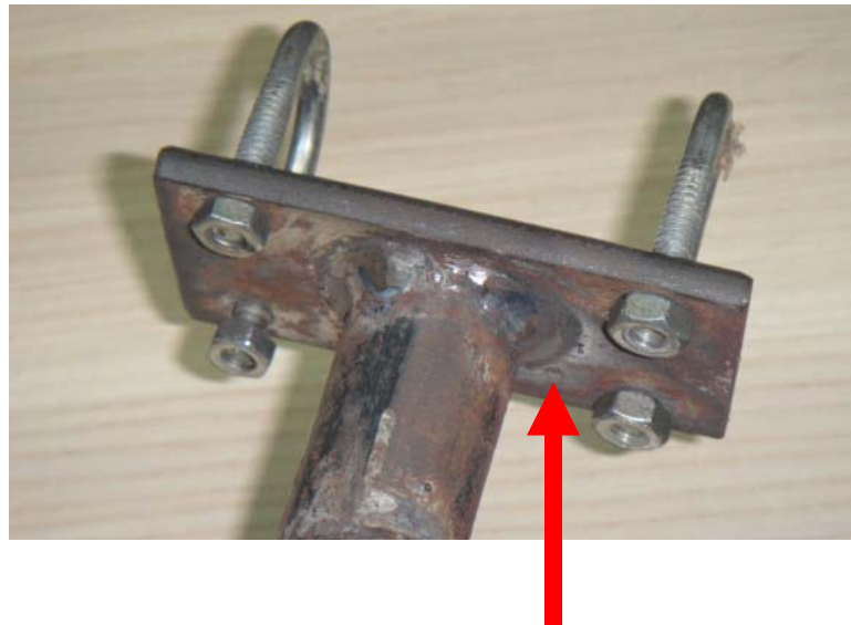
Gambar 10 : Plat besi bersaiz 6mm x 90mm x 50mm dipotong. Empat (4) lubang berdiameter 6mm ditebuk pada plat besi bagi pemasangan U-bolt
